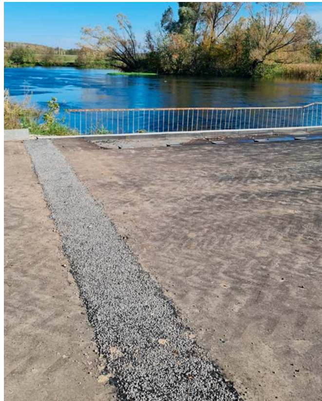
8. Окончание работ по устройству деформационного шва «Thorma Joint».
