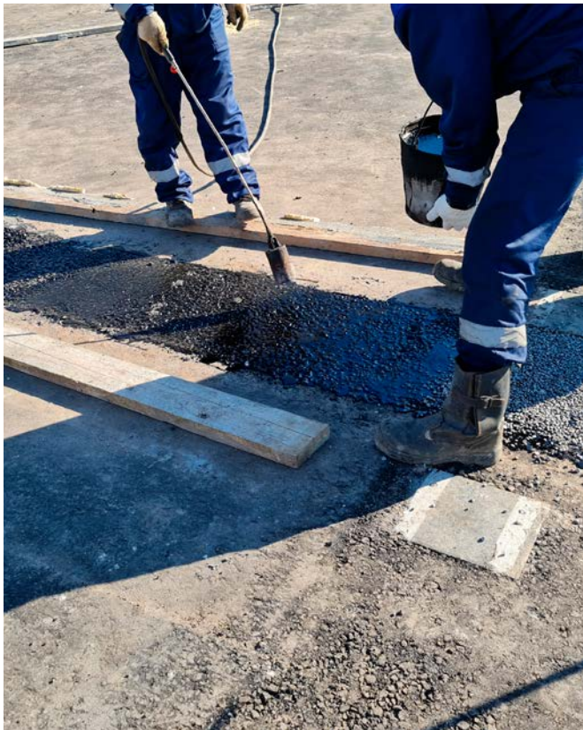
7. Последний слой заполнения камеры деформационного шва толщиной 10–15 мм заполняется гранитным щебнем фракции 2–5 мм и уплотняется виброплитой.
