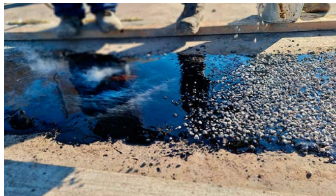
6. Заполнение камеры высокосортным щебнем фракции 10–14 мм нагретым до температуры 160–180 °С слоями толщиной 30–40 мм.
