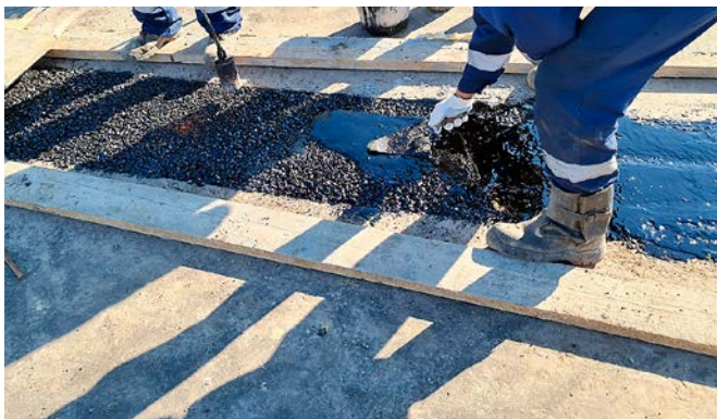
5. Каждый уложенный слой высокосортного щебня заливается Битумно-полимерной мастикой ТЕХНОНИКОЛЬ БПГ-ДШ нагретой до температуры 160–180 °С до полного насыщения зерен щебня.
